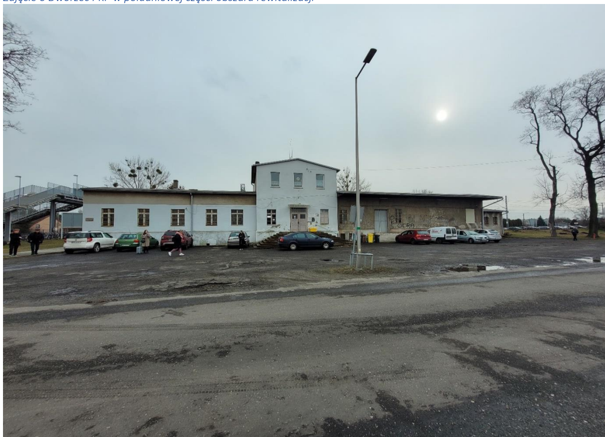
Zdjęcie 6 Dworzec PKP w południowej części obszaru rewitalizacji
